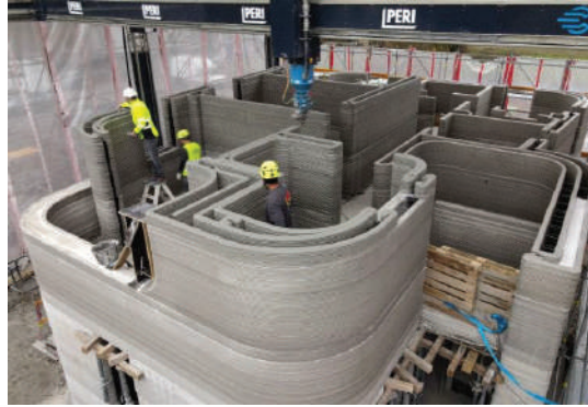
شكل(1) تنفيذ المباني باستخدام الطباعة ثلاثية الأبعاد
